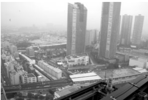
写真：手前が東急武蔵小杉駅、 奥が横須賀線武蔵小杉新駅プラットフォーム
